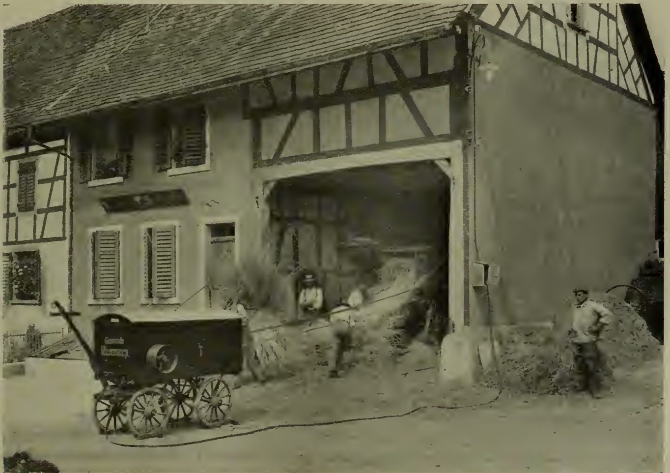
Fig. 183. — Commande d'une batteuse par moteur électrique.
